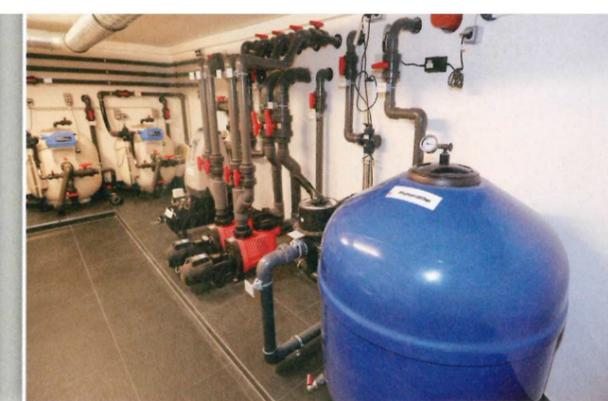
Eine gigantische Technik mit insgesamt elf Pumpen steckt hinter dieser imposanten Anlage von Schleitzer baut Gärten. Schließlich müssen 170 Kubikmeter Wasser permanent bewegt und aufbereitet werden. So hat jeder der vier Skimmer seine eigene Pumpe, zwei Pumpen braucht es für den Wasserfall und fünf Pumpen fördern den Filterkreislauf.
