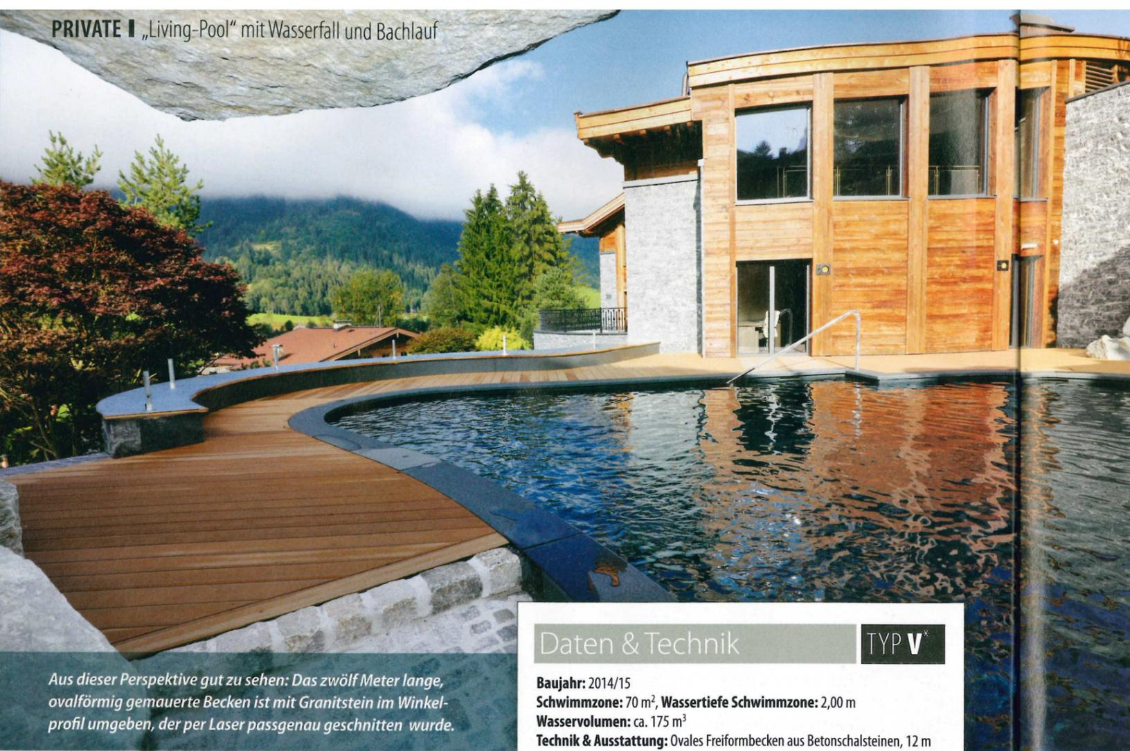
Aus dieser Perspektive gut zu sehen: Das zwölf Meter lange, ovalförmig gemauerte Becken ist mit Granitstein im Winkelprofil umgeben, der per Laser passgenau geschnitten wurde.
